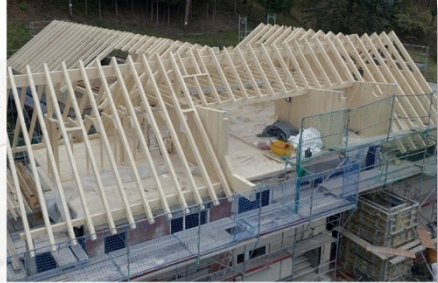
Aufstockung und Dachstuhl
